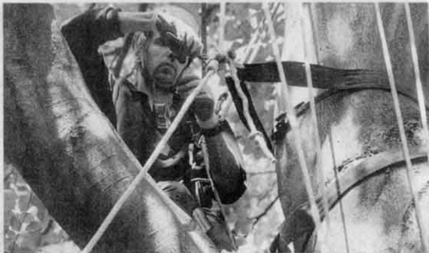
Mit Kronensicherungen und Erdankern sorgte die Bremer Firma Hanseatic Treework gestern dafür, dass ein Naturdenkmal in den Wallanlagen nun wieder ganz stabil da steht. Die gewaltige Buche wurde fast unmittelbar nach der „Entfestigung“ des Walls gepflanzt. FOTO: FRANK THOMAS KOCH
